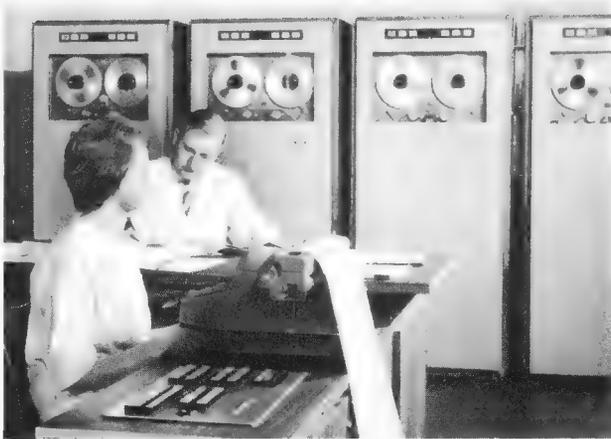
Bild 14. Bedienungspult der Digital-Großrechenanlage TR 4; im Hintergrund Magnetbandspeicher MDS 251 mit Siebenspuraufzeichnung auf 1/2-Zoll-Band. Jede Spule enthält 1080 m Band, ausreichend für 10<sup>7</sup> Zeichen (Telefunken)
