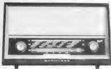
Bild 6. Graetz-Baroness 1109 mit transistorisiertem UKW-Eingangsteil
